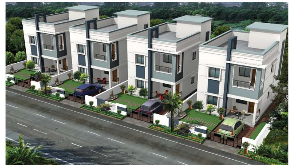
VUDA Duplex Villas, Kothavalasa
